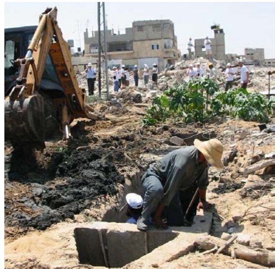
Protection des travaux de réparation de la station de pompage
